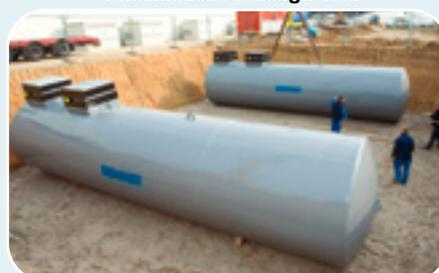
Doppelwandige Tanks für Benzin, Diesel und Heizöl
