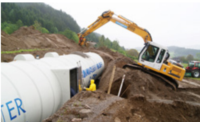
150.000 L Speicher mit mittiger Schieberkammer
