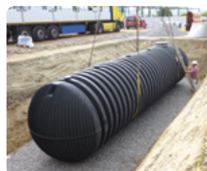
Löschwasserbehälter
