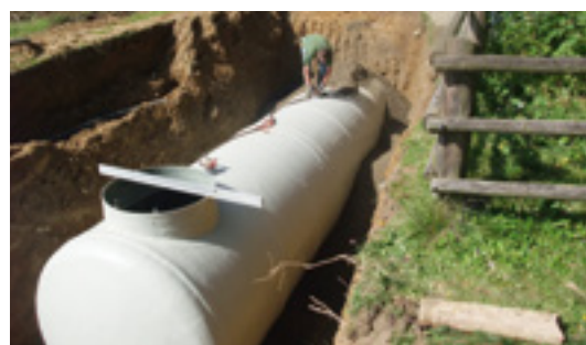
Einbau Trinkwasserspeicher
