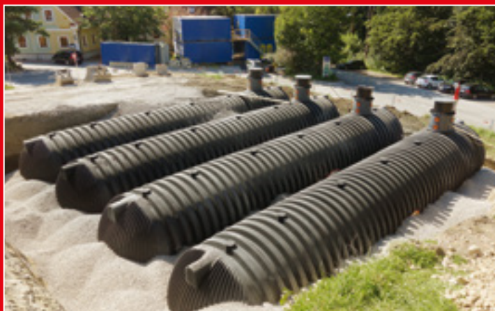
Abbildung zeigt 4 x 56.000 Liter Löschwasserbehälter Carat XXL
