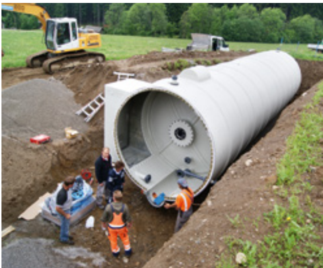
Schieberkammer mittig
