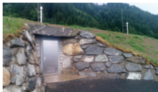
Zugangsbereich mit Steinschichtung
