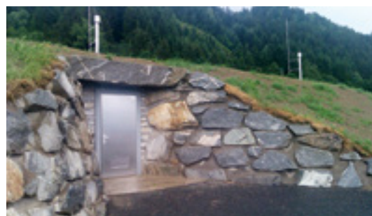
Zugangsbereich mit Steinschichtung
