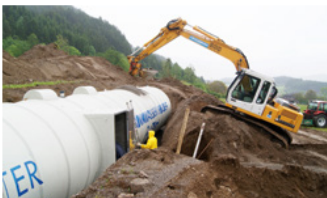
150.000 L Speicher mit mittiger Schieberkammer
