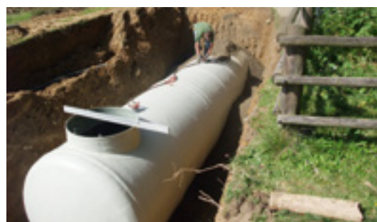
Einbau Trinkwasserspeicher
