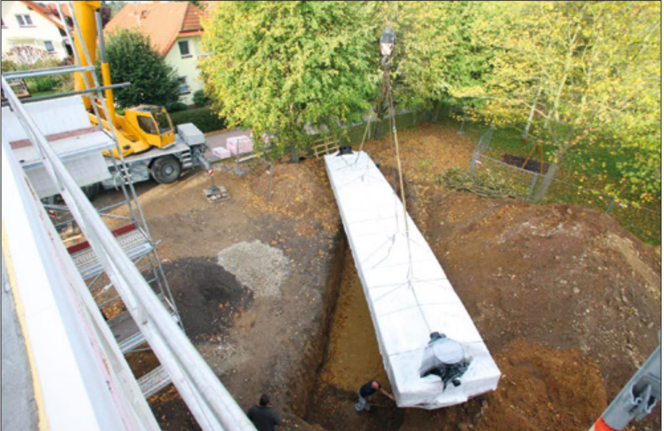
Werkseitig können eingeschweißte Rigolen bis zu einem Volumen von maximal 60 m<sup>3</sup> produziert werden und per Lkw zum Einsatzort transportiert
