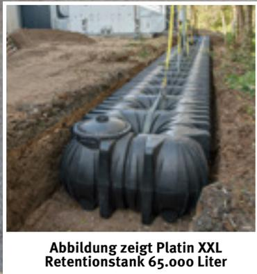
Abbildung zeigt Platin XXL Retentionstank 65.000 Liter
