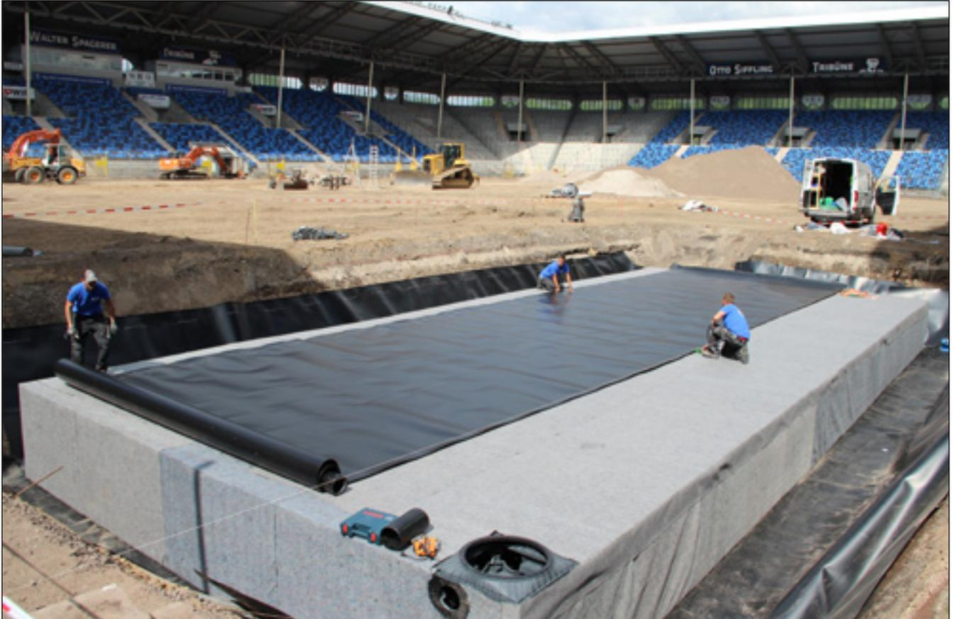
Der Retentionsaufbau vor Ort bietet die Möglichkeit Länge, Breite und Höhe der eingeschweißten Rigolen objektspezifisch zu wählen. Insbesondere
