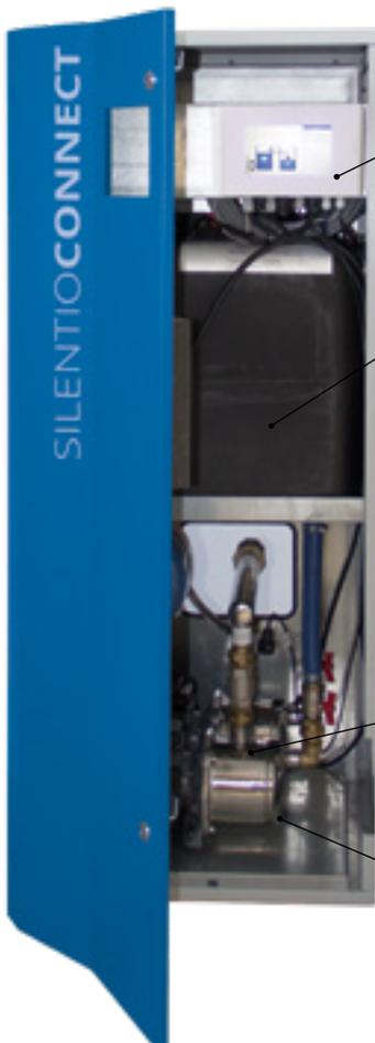
Intelligente Connect Steuerung mit Touch Display
