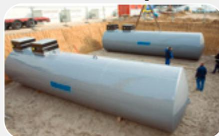
Doppelwandige Tanks für Benzin, Diesel und Heizöl
