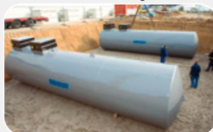
Doppelwandige Tanks für Benzin, Diesel und Heizöl
