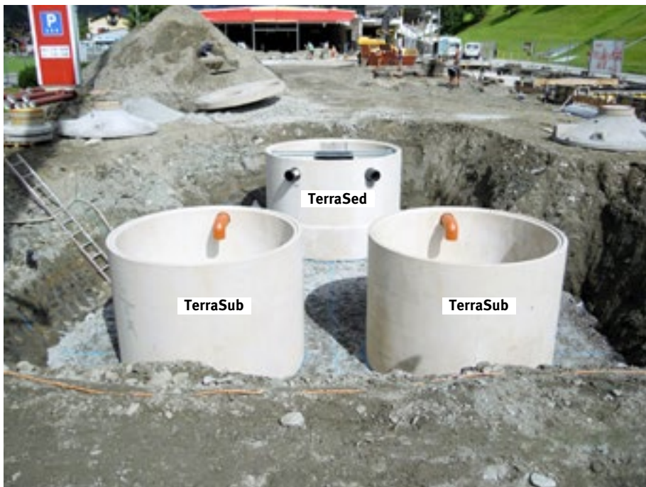
Parkplatzentwässerung mittels TerraSed Sedimentationstank und zwei TerraSub Substratfiltern
