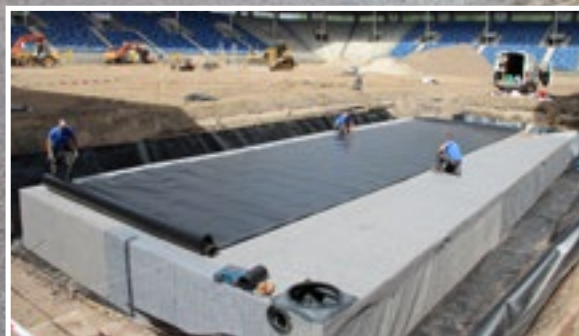
Abbildung zeigt Retention mit EcoBloc Inspect + Folie
