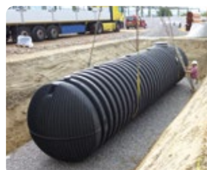
Löschwasserspeicher
