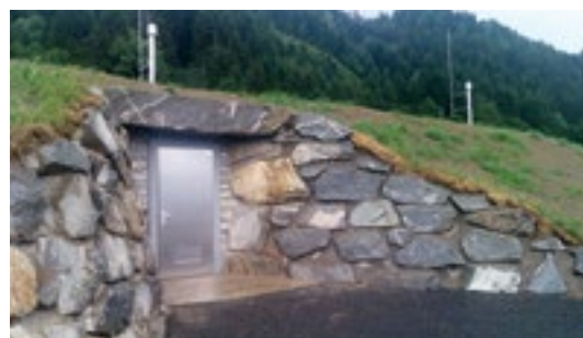
Zugangsbereich mit Steinschichtung
