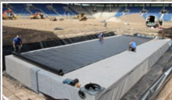
Abbildung zeigt Retention mit EcoBloc Inspect + Folie
