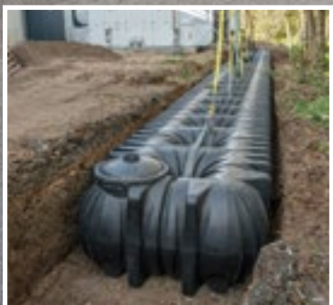
Abbildung zeigt Platin XXL Retentionstank 65.000 Liter
