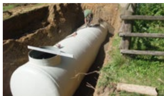
Einbau Trinkwasserspeicher
