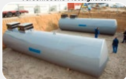
Doppelwandige Tanks für Benzin, Diesel und Heizöl
