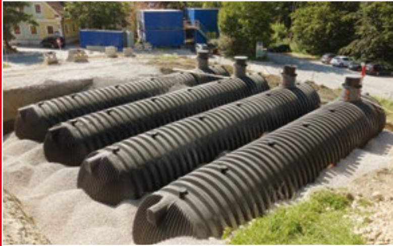
Abbildung zeigt 4 x 56.000 Liter Löschwasserbehälter Carat XXL
