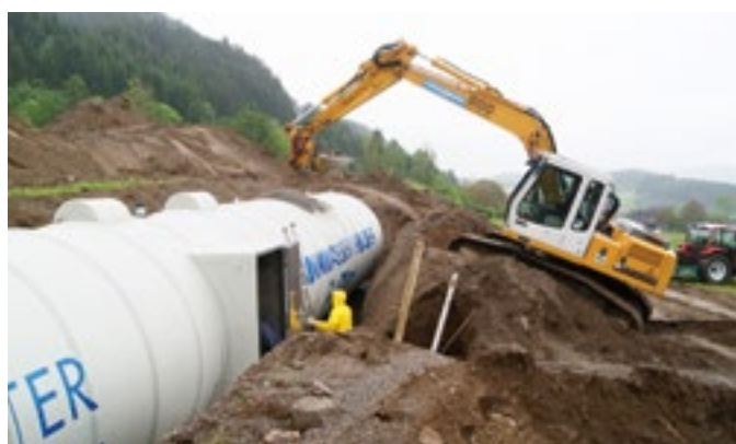
150.000 L Speicher mit mittiger Schieberkammer
