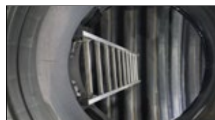
Einstiegsschacht Einstiegsleiter für Wartungsarbeiten
