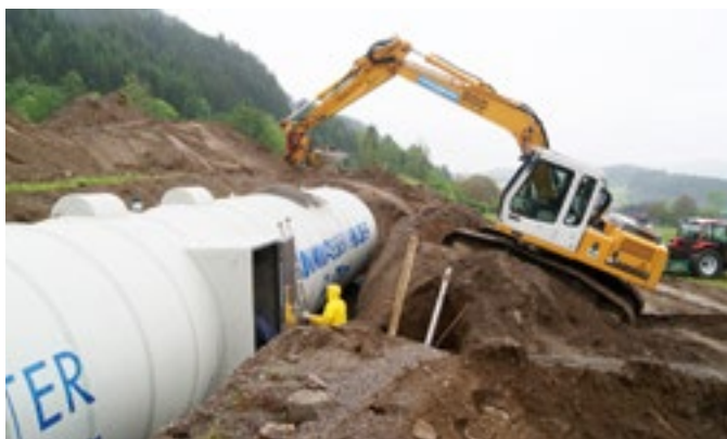
150.000 L Speicher mit mittiger Schieberkammer
