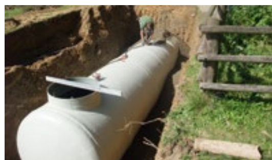
Einbau Trinkwasserspeicher
