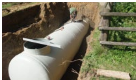
Einbau Trinkwasserspeicher
