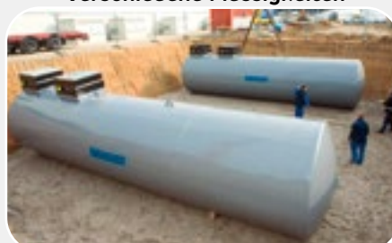
Doppelwandige Tanks für Benzin, Diesel und Heizöl
