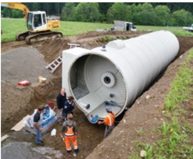
Schieberkammer mittig
