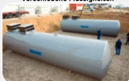
Doppelwandige Tanks für Benzin, Diesel und Heizöl
