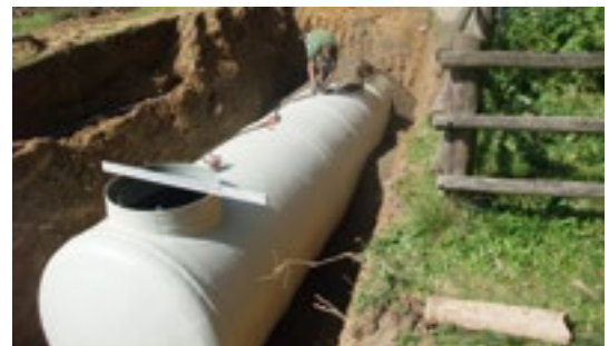
Einbau Trinkwasserspeicher
