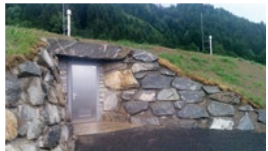
Zugangsbereich mit Steinschichtung
