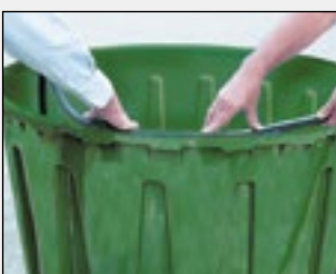
Dichtung einsetzen
