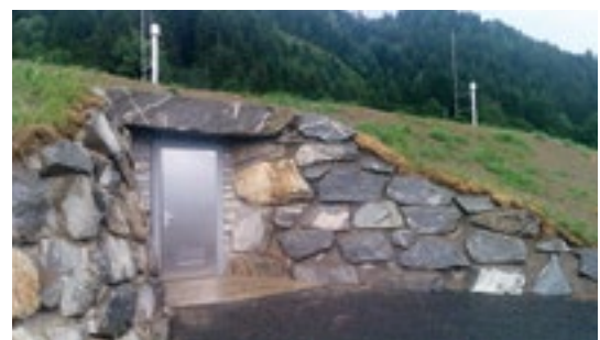
Zugangsbereich mit Steinschichtung
