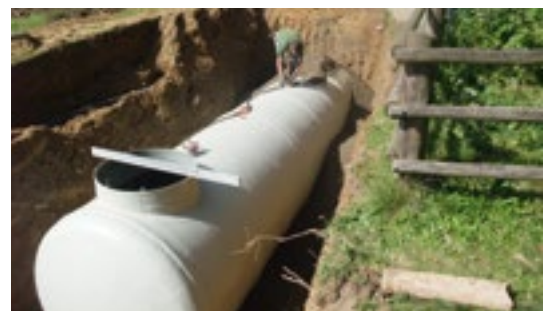
Einbau Trinkwasserspeicher
