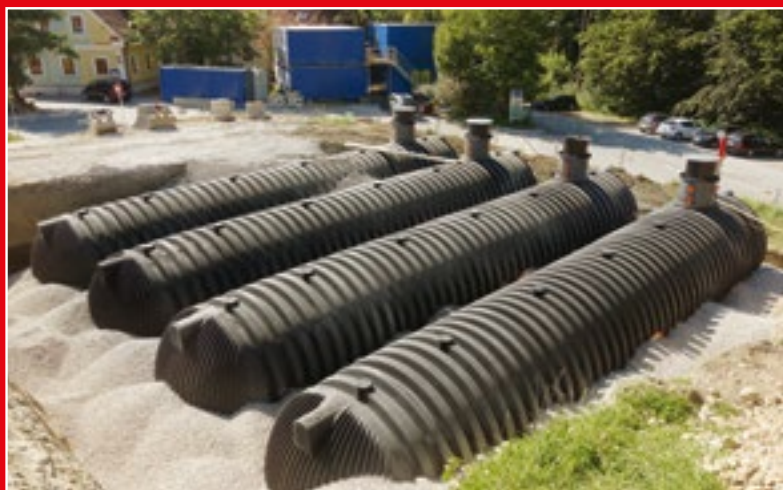
Abbildung zeigt 4 x 56.000 Liter Löschwasserbehälter Carat XXL
