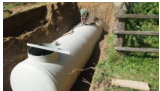
Einbau Trinkwasserspeicher
