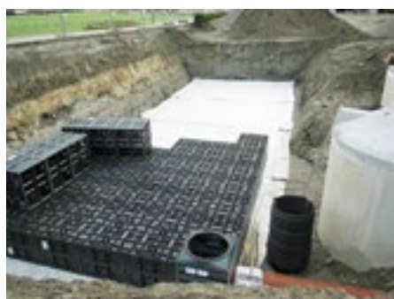
Die Versickerung des gereinigten Wassers erfolgt unterirdisch (ohne Platzverlust an der Oberfläche) über GRAF EcoBloc
