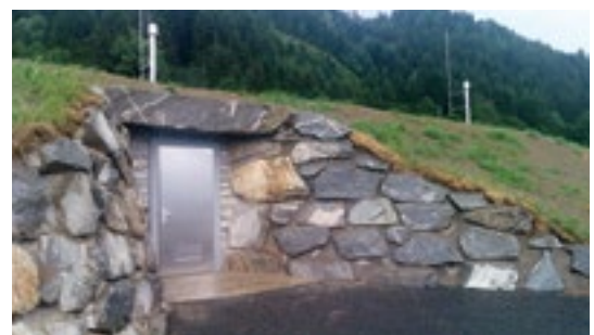
Zugangsbereich mit Steinschichtung
