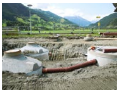
Parkplatzentwässerung mittels TerraSed Sedimentationstank und zwei TerraSub Substratfiltern
