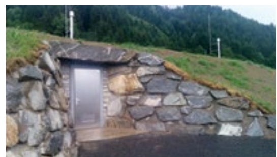
Zugangsbereich mit Steinschichtung
