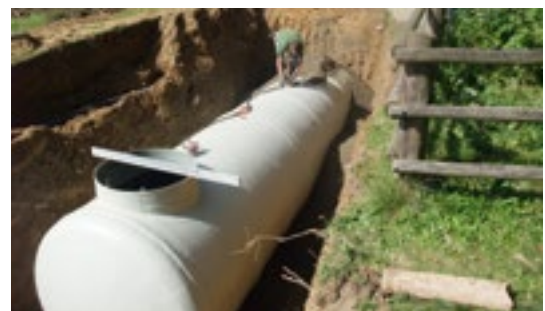
Einbau Trinkwasserspeicher
