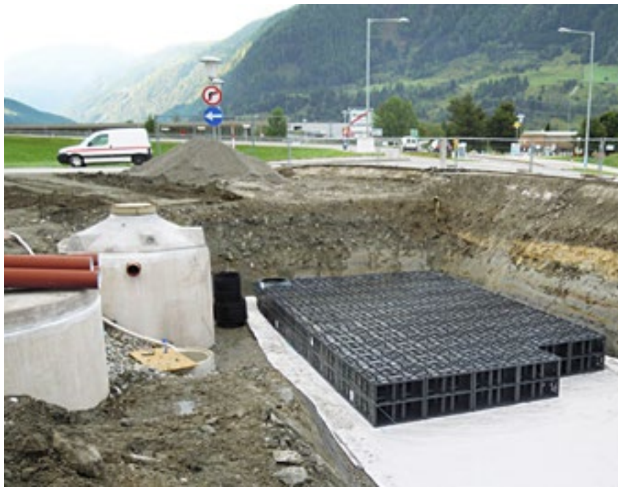
Die Versickerung des gereinigten Wassers erfolgt unterirdisch (ohne Platzverlust an der Oberfläche) über GRAF EcoBloc
