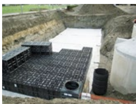
Die Versickerung des gereinigten Wassers erfolgt unterirdisch (ohne Platzverlust an der Oberfläche) über GRAF EcoBloc
