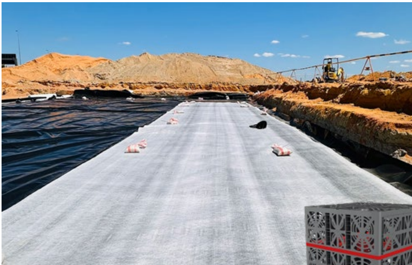
Abbildung zeigt GRAF Rigolenkörper, die mit GeoSorp PFAS als zusätzliche Filterbarriere eingeschlagen sind
